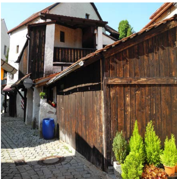
Nebengebäude in traditioneller Holzbauweise
