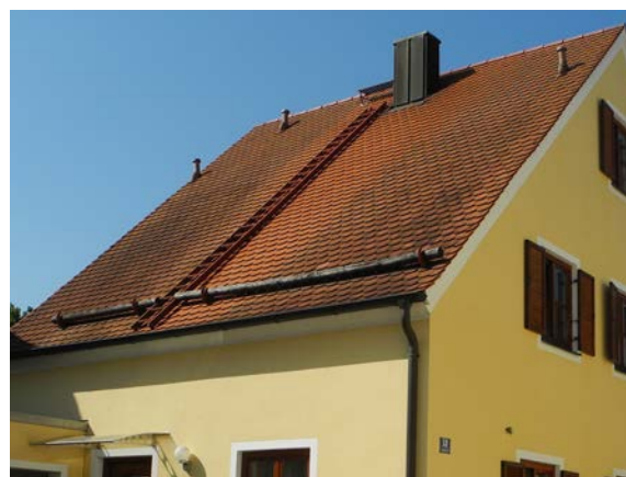
ungestörte Dachfläche eines typischen Satteldaches
