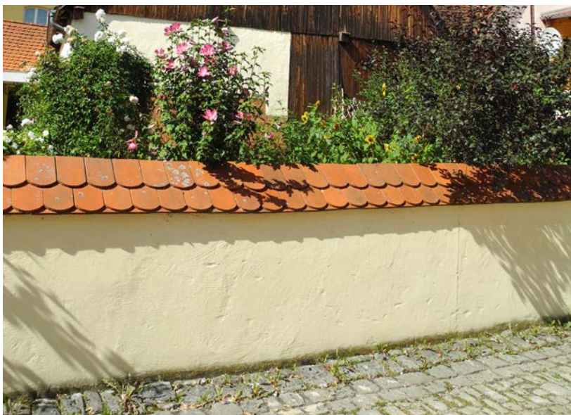
verputzte Mauer, Abdeckung mit Biberschwanzziegeln
