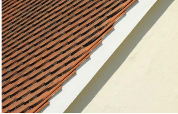
Eindeckung mit Biberschwanzziegeln
