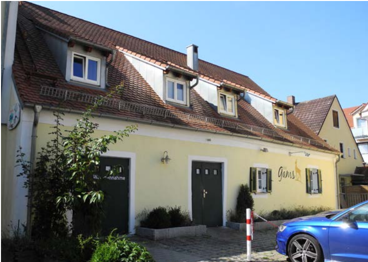
18. Jahrhundert Schneider-Peterle-Gasse 2, Wohnhaus erdgeschossiger Steildachbau Baudenkmal gut saniert, aber Dachfläche durch vier Schleppgauben gestört
