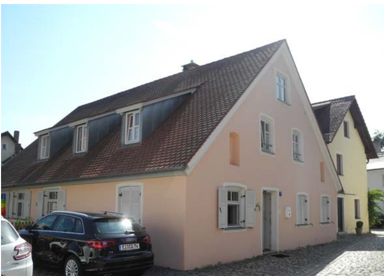
19. Jahrhundert Buchbindergasse 9, ehem. Wohnhaus erdgeschossig mit zwei Nischen für Figuren Baudenkmal gut saniert, aber Dachfläche durch Schleppgauben gestört
