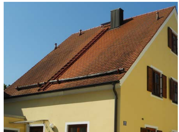
ungestörte Dachfläche eines typischen Satteldaches
