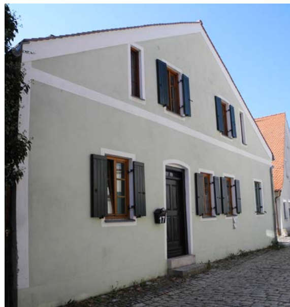
harmonische Fassadenansicht durch fassadengliedernde Putzbänder und fehlende Sockelzone
