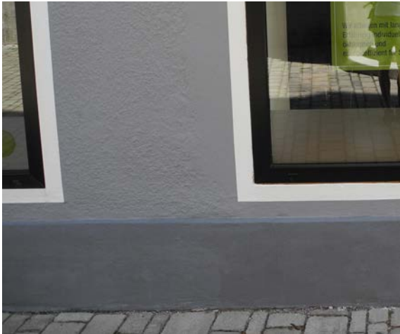
farblich geringfügig abgesetzte Sockelzone
