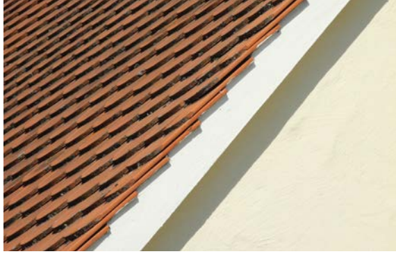
Eindeckung mit Biberschwanzziegeln
