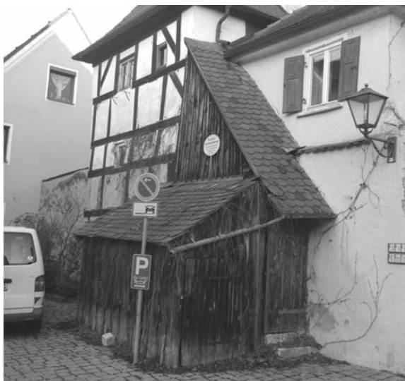
Erfolge der Stadtsanierung: der Seelennonnenturm vor und nach der Sanierung
