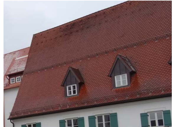
Steildach mit ruhigen, geschlossenen Dachflächen
