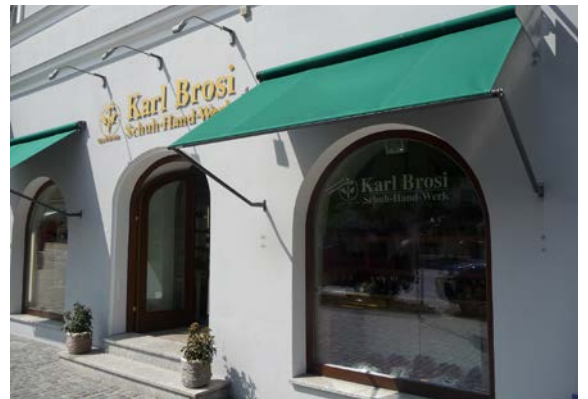
akzeptable Markise (Beispiel aus Regensburg)
