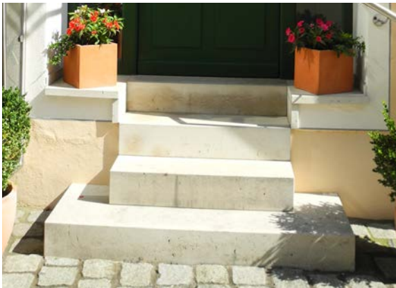
Gebäudezugang mit Natursteinstufen
