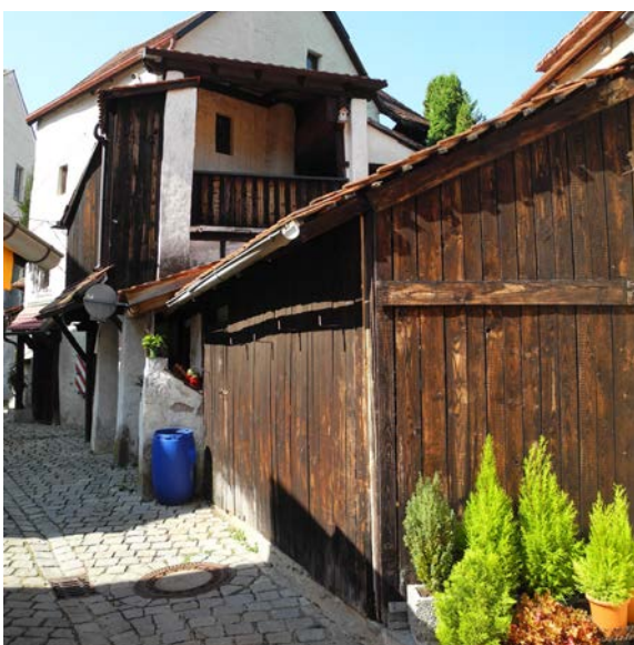
Nebengebäude in traditioneller Holzbauweise
