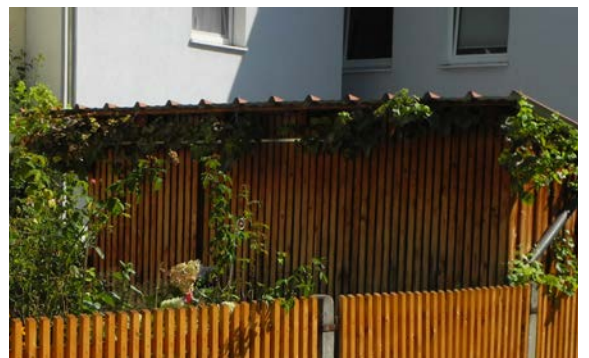
Nebenanlagen mit senkrechter Holzlattung
