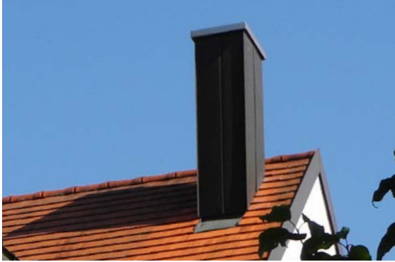
Schornstein nahestehend am First
