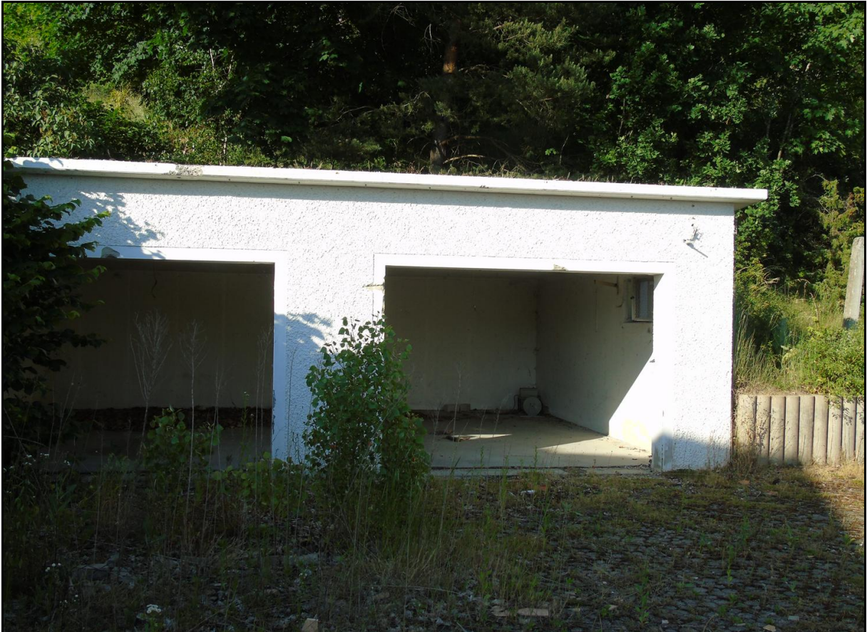
Abbildung 3: Garagenbereich ohne Verschalungen
