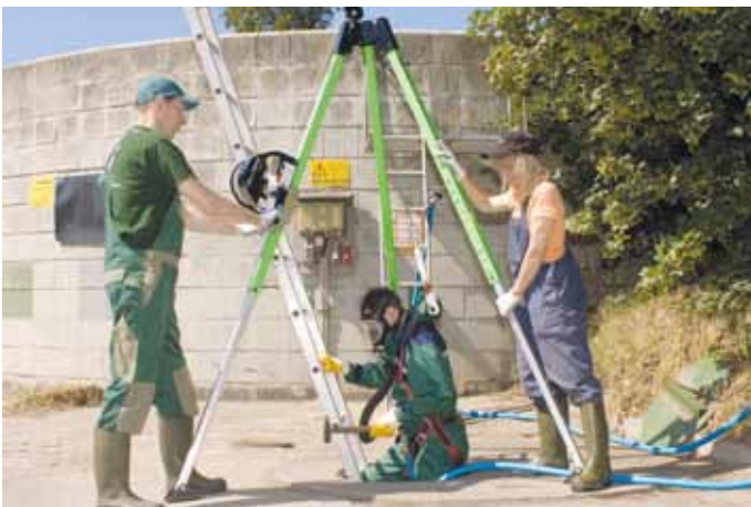
Einstieg ins Güllelager am Rettungsgurt mit einem umluftunabhängigen Frischluftgerät – gesichert durch zwei Personen. Foto: SVLFG
