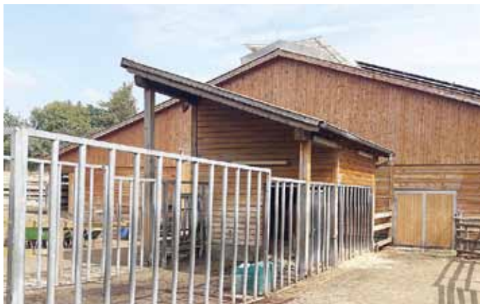
Über den Laufhof haben Kühe und Bullen die Möglichkeit, Kontakt aufzunehmen. Senkrechte Streben bilden eine stabile Einzäunung und ermöglichen dem Tierbetreuer gegebenenfalls die Flucht über die gesamte Länge der Deckbullenbucht.
