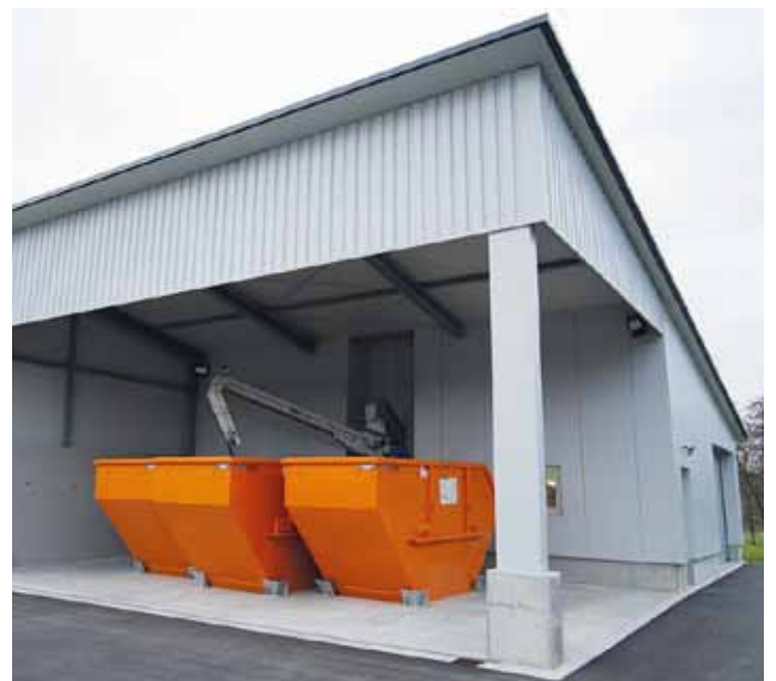
Neues Entwässerungsgebäude mit Muldenbefüllung
