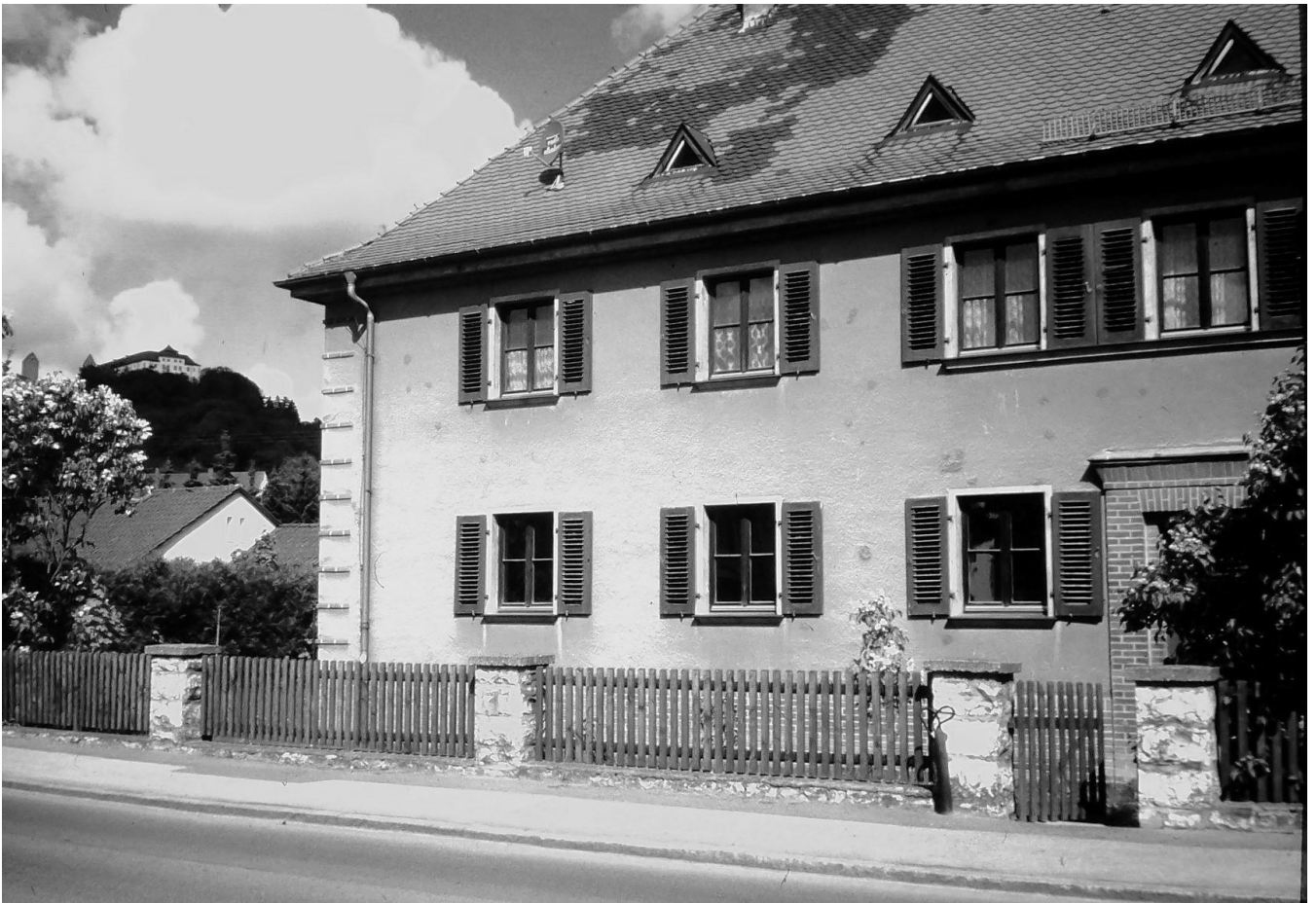
Das Wohnhaus für Finanzbeamte an der Eichstätter Straße
